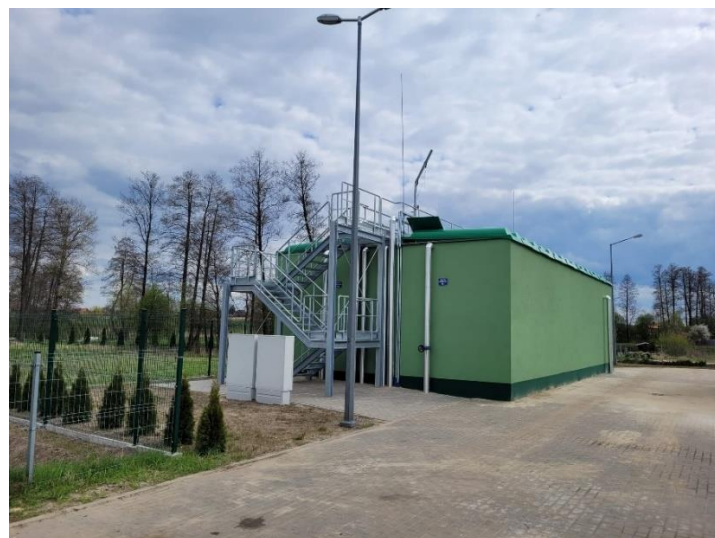
Rozbudowa oczyszczalni ścieków w Kłoczewie
