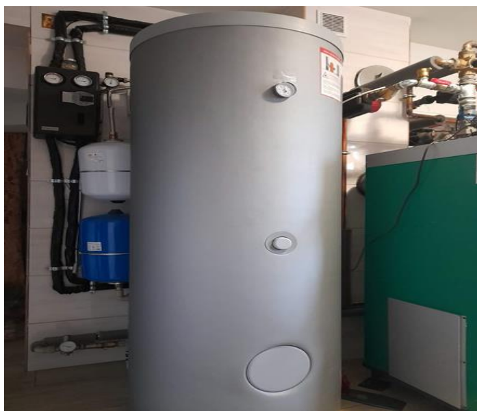
Dostawa i montaż instalacji solarnych
