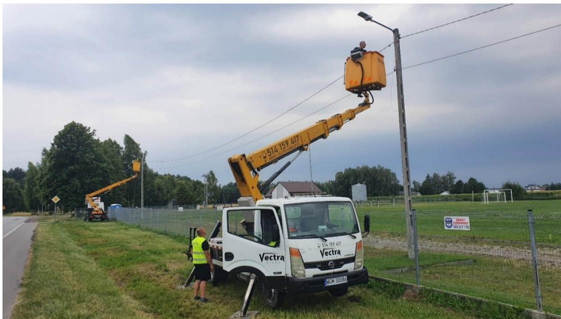
Modernizacja linii oświetlenia ulicznego
