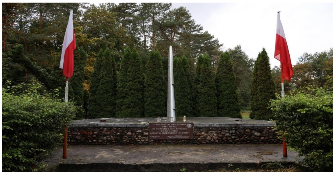
Pomnik wraz z zagospodarowaniem przeznaczony do remontu
