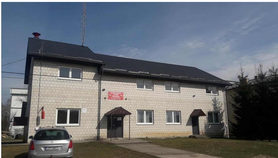
Wymieniony dach na budynku świetlicy wiejskiej w Starym Zadybiu – wymiana dachu
