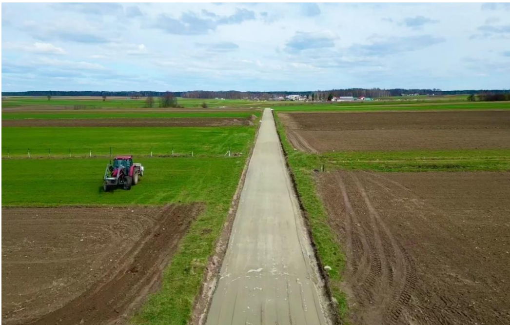
Modernizowany odcinek drogi w miejscowości Gózd
