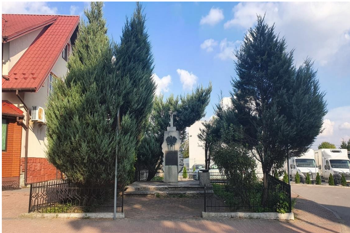
Skwer przeznaczony do remontu- stan aktualny
